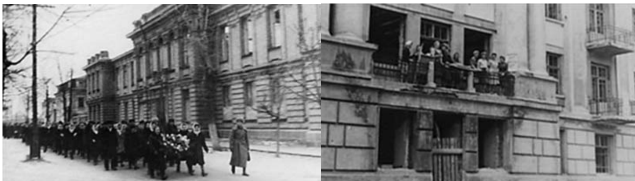
1946 рік. Корпус № 1 ПДПІ. Відбудова гуртожитку (тепер – корпус № 3)
