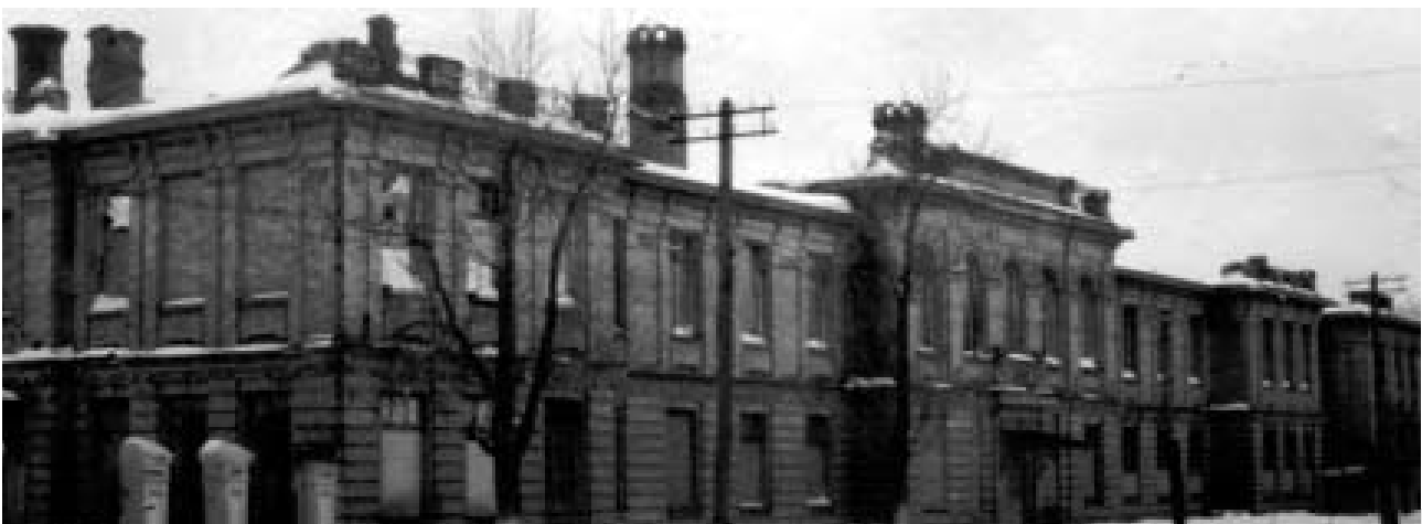
Напівзруйнована будівля педінституту (нині – корпус № 1) наприкінці війни.
