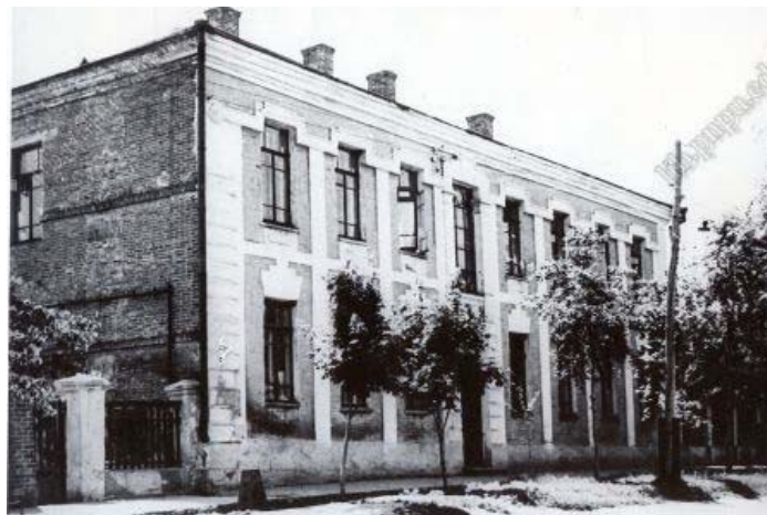
Будинок колишнього Полтавського вчительського інституту на вул. Фабрикантській, 1 (тепер вул. Балакіна, 10). Фото 1950-х років з фондів науково-дослідної лабораторії А. С. Макаренка Полтавського педуніверситету
