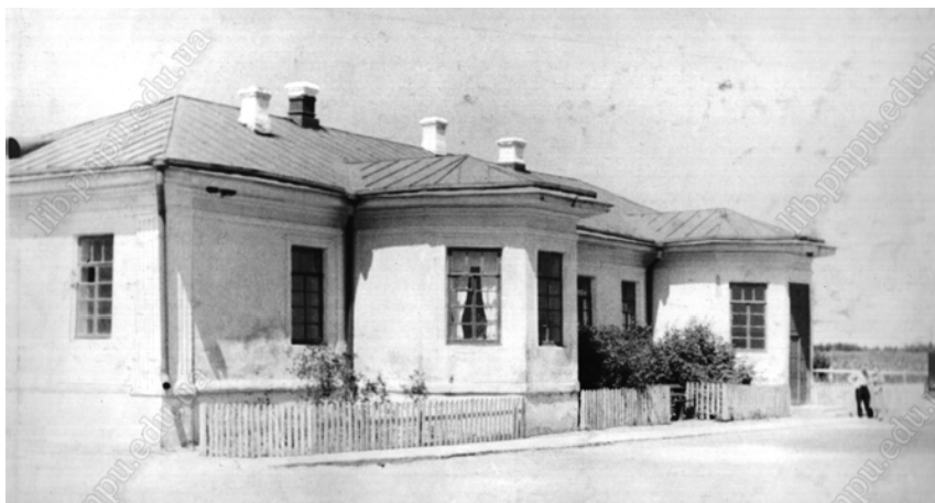
Садиба II-ї колонії: загальний вигляд із східного боку будівлі літ. Б (фото Стриженова, 1950–60-ті рр., надане Н. В. Куценко, фонди Музею А. С. Макаренка Кременчуцької міської ради Полтавської області)
