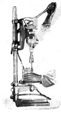
Нарезает отверстия в станине
