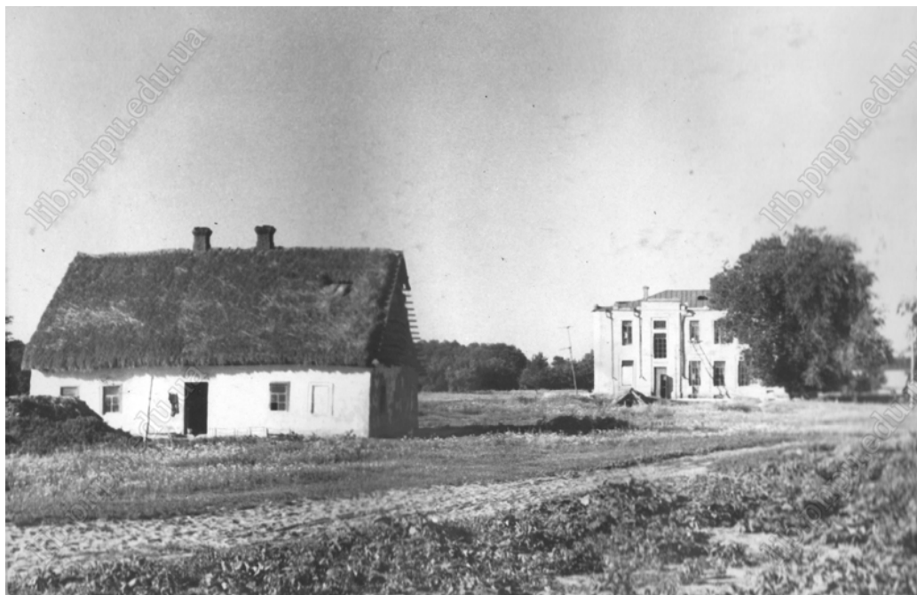
Північно-західна частина II-ї колонії. Ліворуч будівля літ. Ж (?), на другому плані будівля літ. В (фото Стриженова, 1950–60-ті рр., надане Н. В. Куценко, фонди Музею А. С. Макаренка Кременчуцької міської ради Полтавської області)
