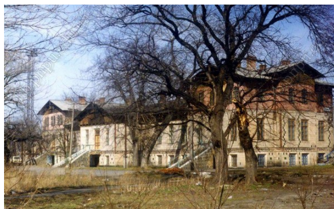
Старий крюківський вокзал у 2002 р. перед реконструкцією ( http://static.panoramio.com/photos/original/93864456.jpg )
