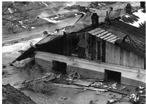
Рис. 2. Зруйнований лавиною будинок
